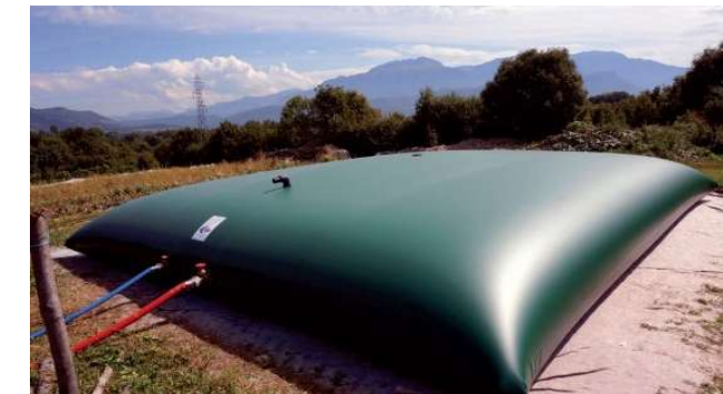
Figure 5 : Exemple de citerne incendie souple
