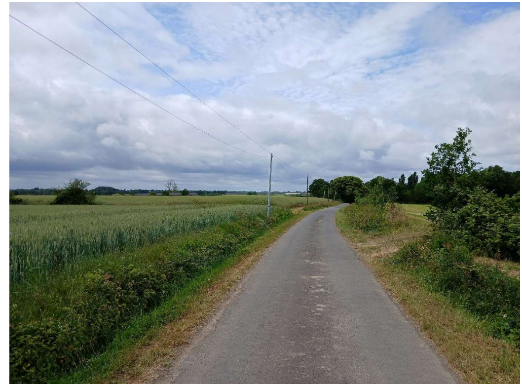
Illustration 6 Vue 2 - Installation sans mesure
