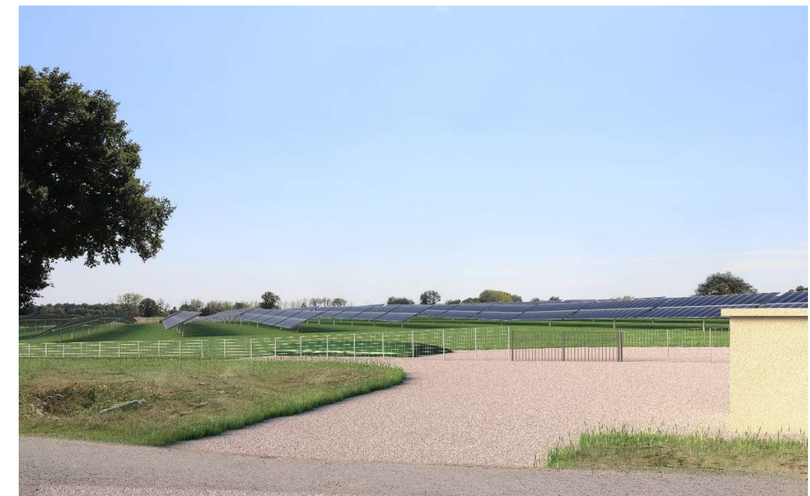
Illustration 3 Vue 1 - Installation sans mesure
