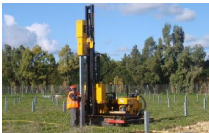
Ancrage des pieux battus
