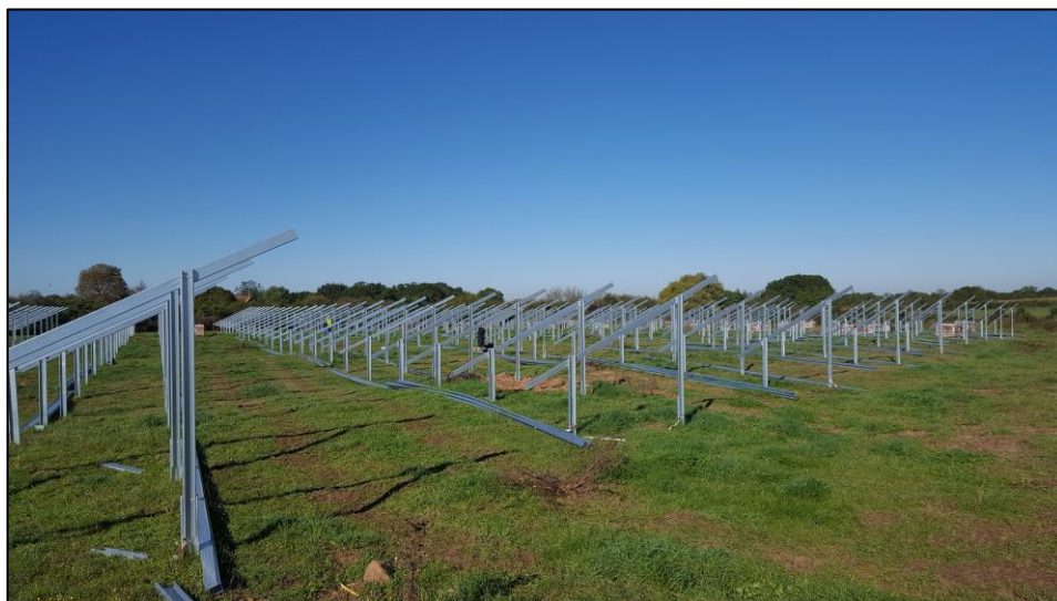
Mise en place des structures sur pieux battus, ici en bi-pieux (centrale JPee de Braize, 03),
