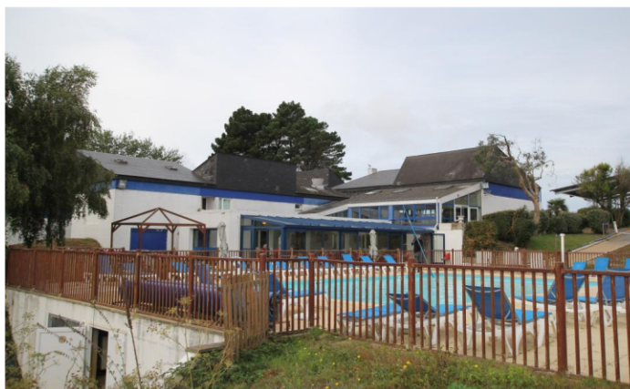
photo 2 - vue sur bâtiment central
