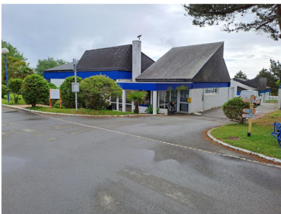
photo 3 - vue sur bâtiment central
