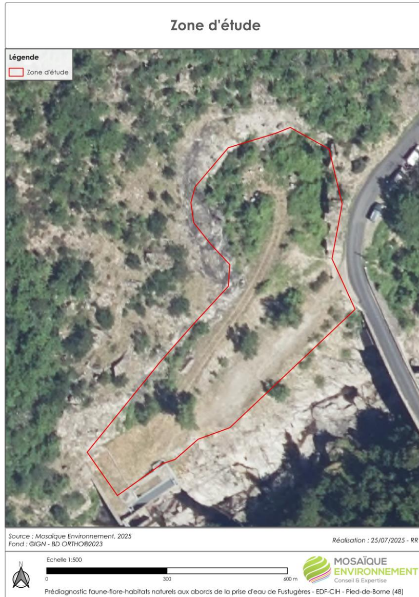
Figure 17 : Zone d'étude au droit de la prise d'eau de Fustugères
