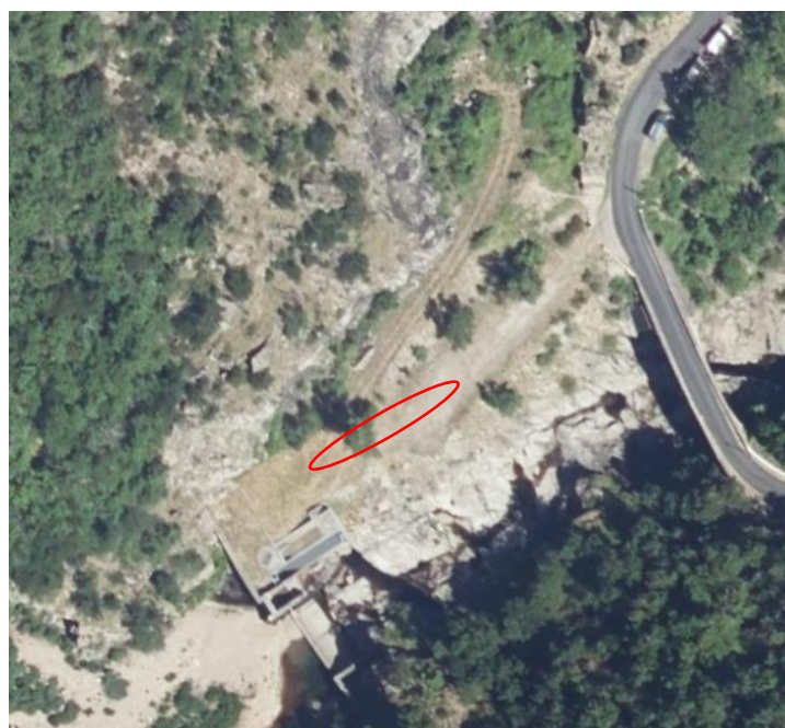
Figure 8 : Zone envisagée pour les installations de chantier (source : Géoportail)
