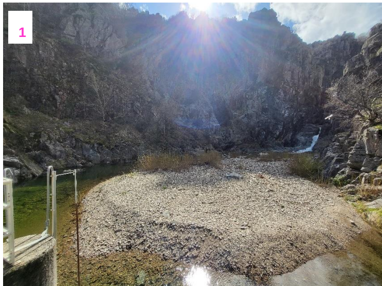
Figure 5 : Atterrissement dans la prise d'eau (1), vue de l'aval depuis l'ouvrage (2) (source : EDF 28/03/2024)
