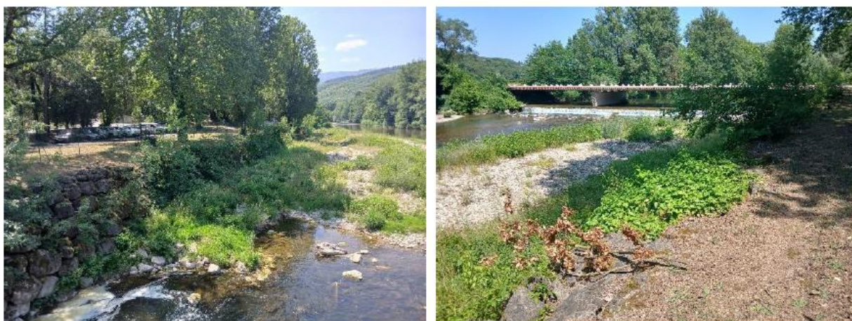
Berge de l'Orb avec enrochements côté site industriel
