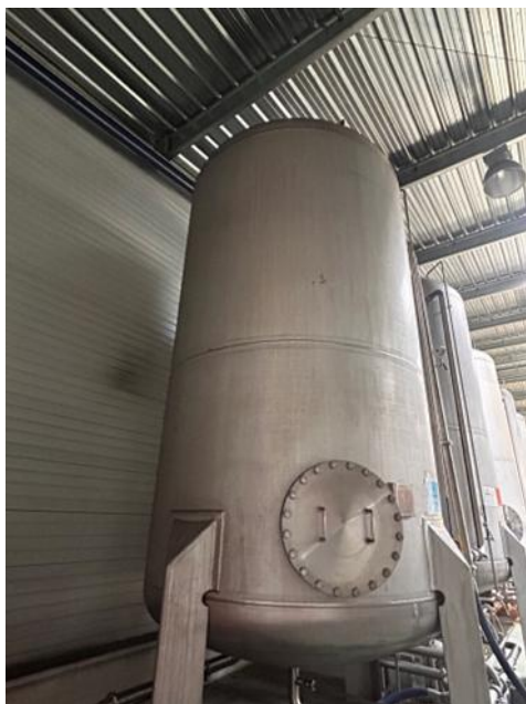
Figure 25 : Tour de filtration sur sable manganifère
