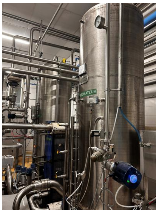
Figure 27 : Carbonateur
