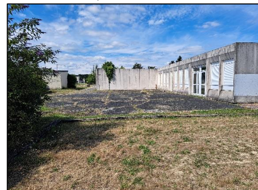
Vue depuis le Sud → centre
