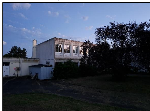
Vue depuis le centre Est → Sud
