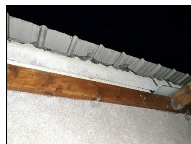
Dessous de toiture ondulée
