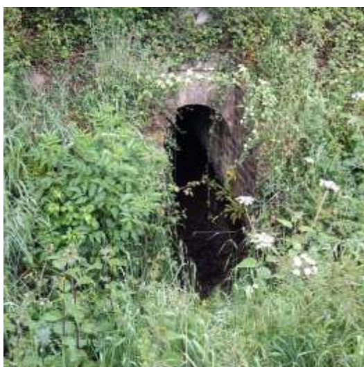
Ouvrage traversant les voies SNCF
