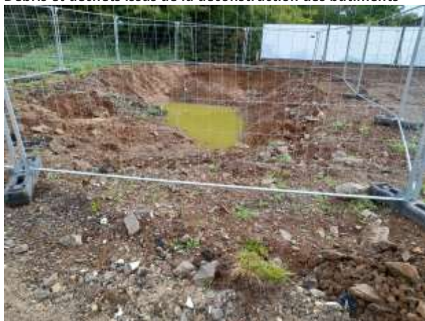
Emplacement de la cuve sur la parcelle centrale
