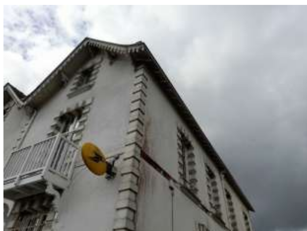
Toiture favorable à la nidification des hirondelles
