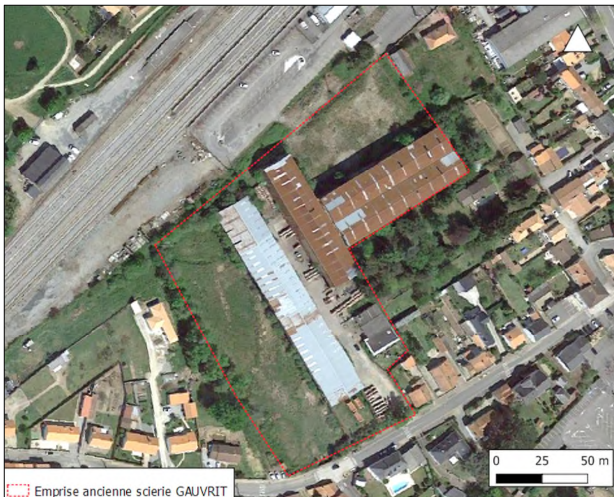
Figure 1 : Localisation du site d'étude (Géoportail modifié, 2021)
