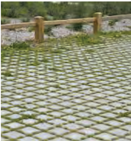
pavés drainants en stationnement
