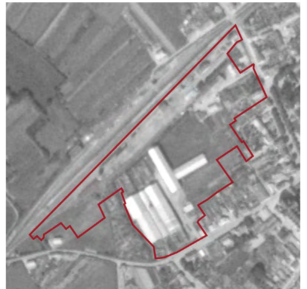
SITE GAUVRIT APRES - Vue aérienne datant de 1965
