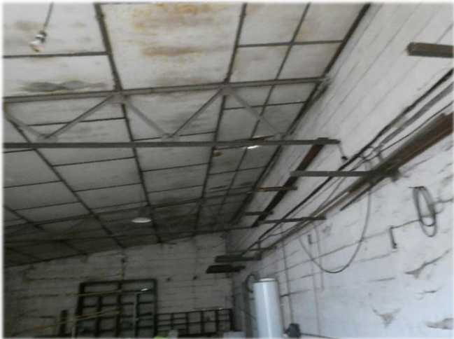
Garage annexe à la maison – absence de gîte
