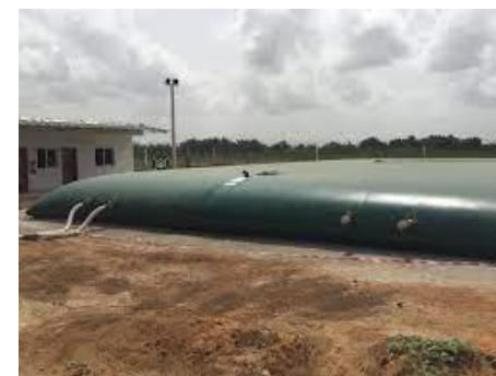
Stockage de fluids pour chantier
