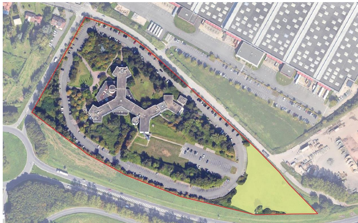
Espace intéressant pour la création d'une pépinière végétale
