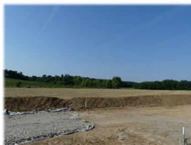
Piste de chantier
