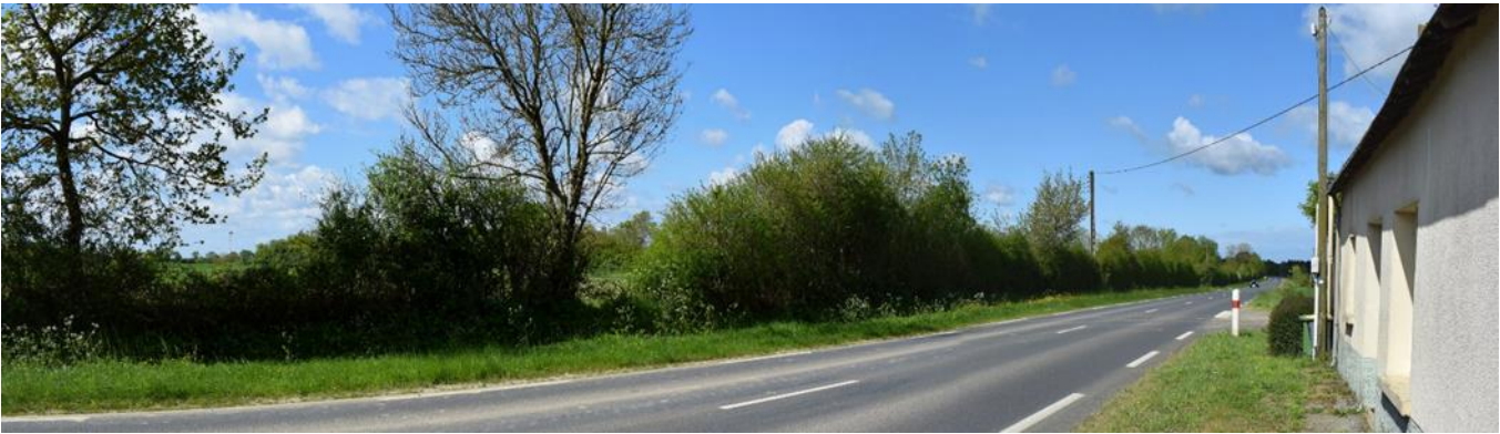
Figure 18 : Depuis la D163 au niveau du lieu-dit Les Rochers à environ 220m de la ZIP
