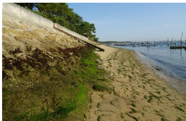
FIGURE 30 : PERRES MAÇONNES OBSERVES AU NORD DE LA PLAGE DES AMERICAINS (CASAGEC, 2020).
