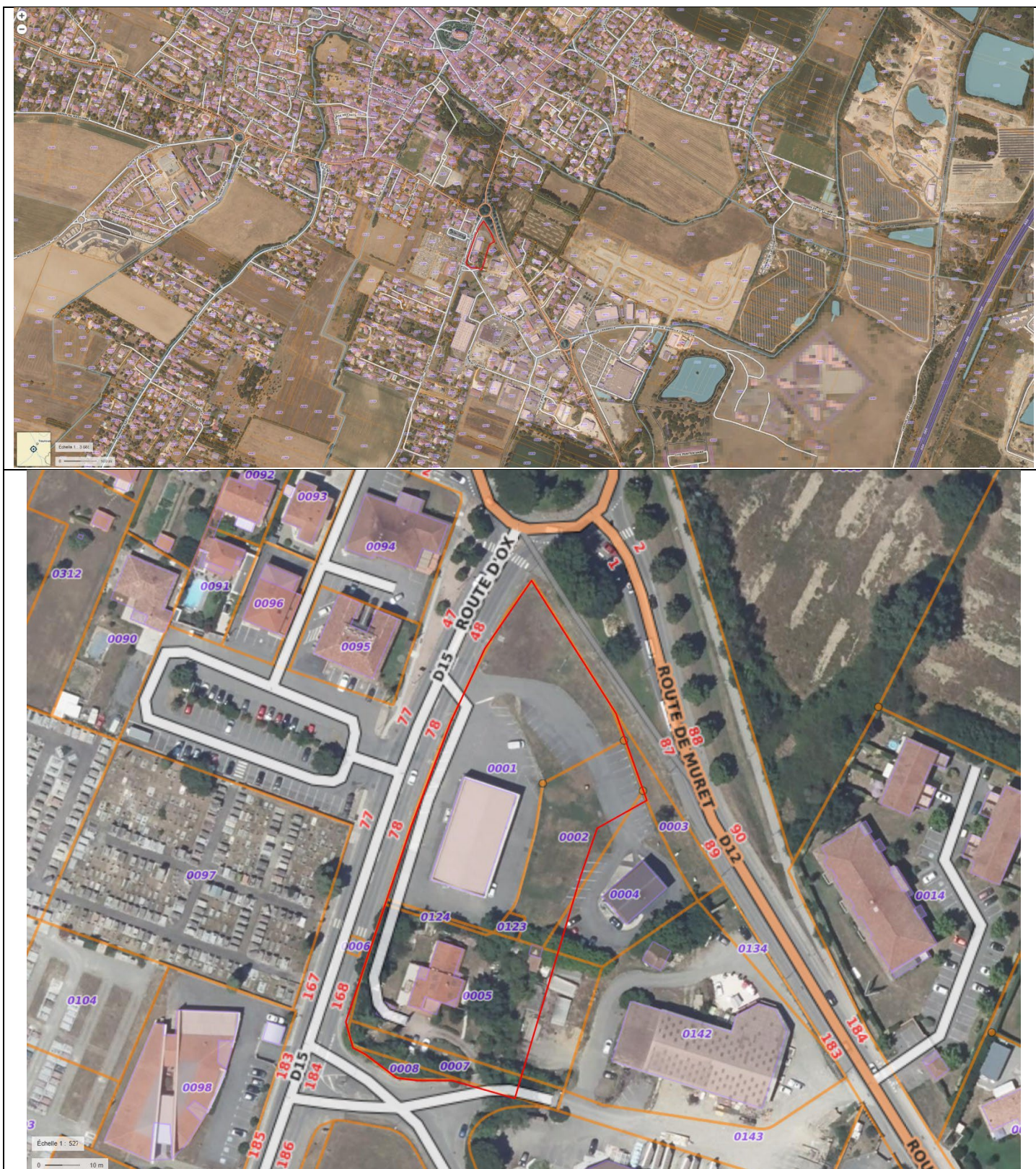
Fig. 1 : Située au sud du centre urbain, le bâtiment commercial est bordé par son parking au nord et partage l'accès à un magasin à l'est (Cofidoc Seysses). Implanté dans une zone mixte de la commune (commerce, service, etc....mais aussi locaux artisanaux et habitat pavillonnaire). ; le projet est situé le long d'artères circulantes à la limite de l'habitat pavillonnaire au nord et une zone d'activité au sud (Piche).
