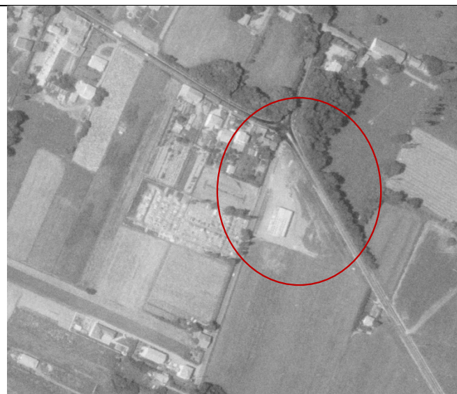
Le cliché du 19/06/1979 montre l'installation de la plateforme, la construction du hangar. Le mur de soutènement de la RD. 15 est en cours d'aménagement (talus)
