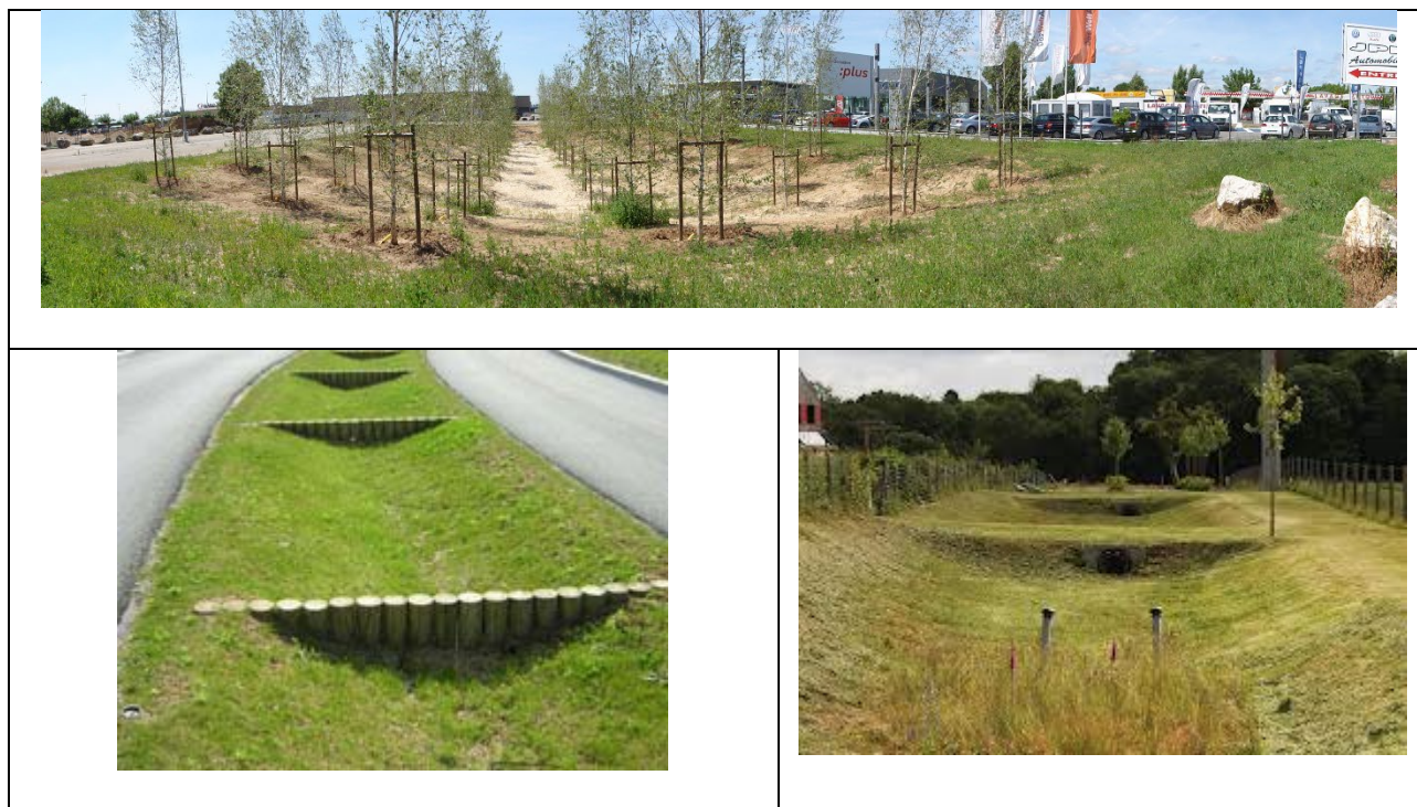
Fig. 8bis - Noues avec ouvrages de sédimentation/ralentissement.
