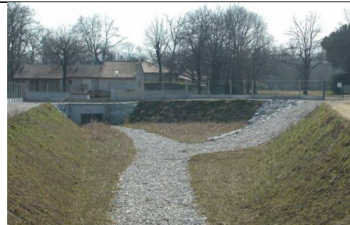
Fig. 8 - Vues de bassins sec aérien planté d'arbres ou non alimenté par déversement direct du pluvial d'un parking ou bien par un réseau).
