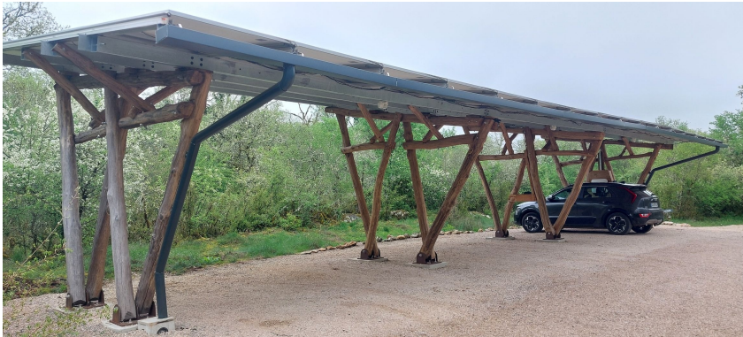
Exemple d'abri-voiture photovoltaïque
