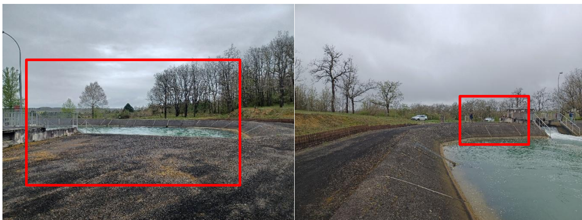
Figure 19 : Vue du site de Pourroutounat avec localisation de l'emplacement de la future microcentrale
