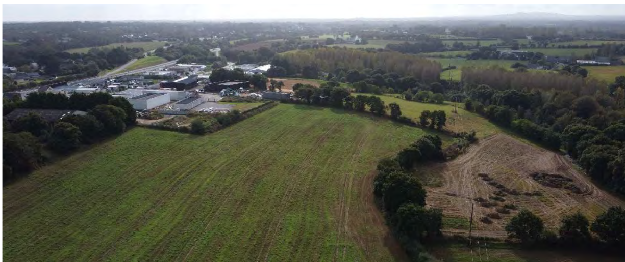
Vue de la partie sud du site
