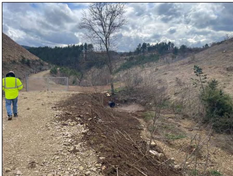
Figure 5 : Vue sur le busage du Valat de Rivemale en limite sud du projet et sur le portail existant qui sera conservé (entrée secondaire) -Source : EMC 48, 25/03/2025
