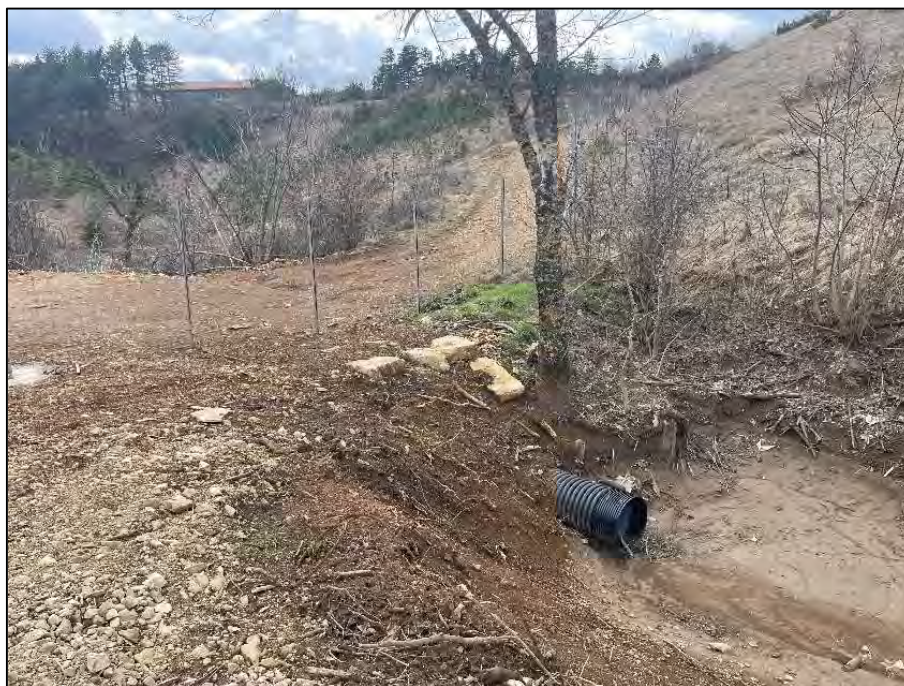
Figure 4 : Vue sur le busage du Valat de Rivemale en limite sud du projet et sur la clôture existante qui sera conservée -Source : EMC 48, 25/03/2025
