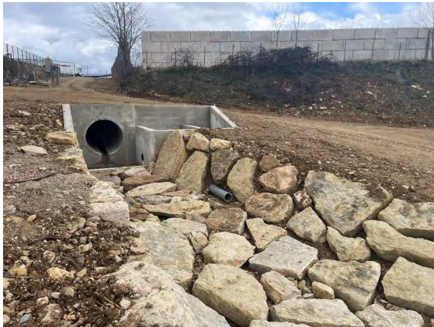
Figure 2 : Busage du Valat de Rivemale situé à proximité immédiate de l'entrée principale au Nord-Est du projet -Source : EMC 48, 25/03/2025
