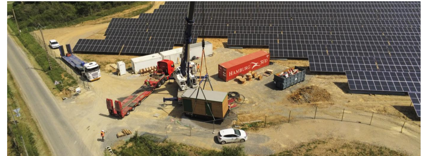
Figure 48 : Photo d'une base de vie et de stockage d'un chantier
