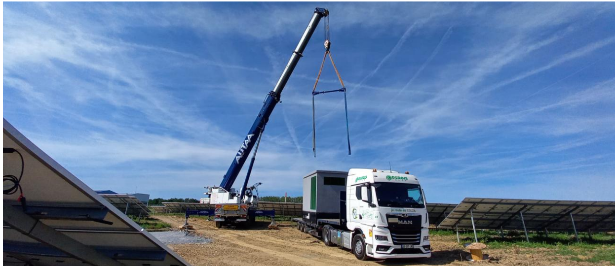
Figure 50 : Installation d'un local technique
