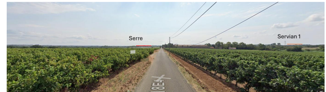
Figure 3. Vue sur les installations depuis le projet d'APEX ENERGIES
