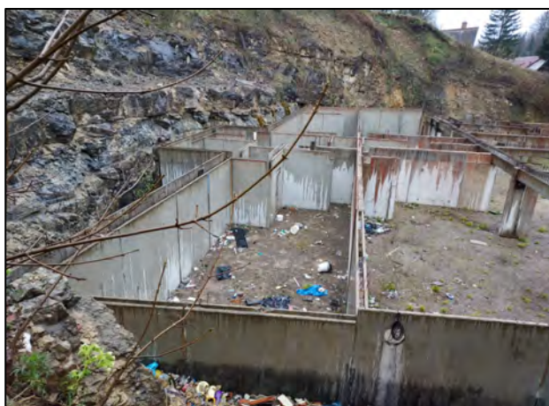
Photographie 9 : Séparateur d'hydrocarbures
