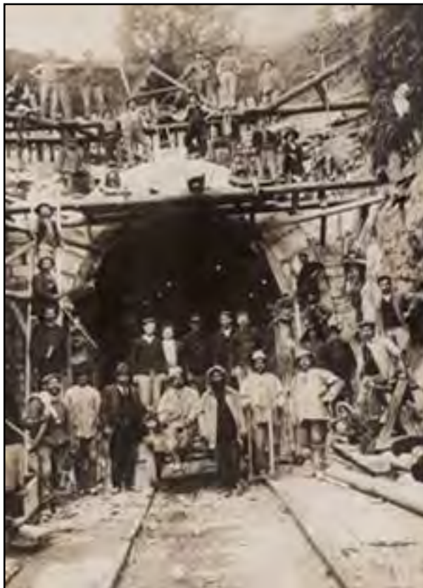
Le tunnel en construction (probablement la sortie)
