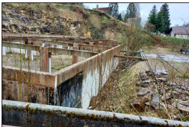
Photographie 9 : Séparateur d'hydrocarbures
