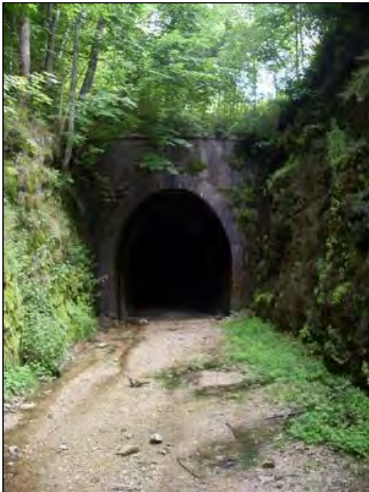
La sortie du tunnel après son nettoyage
