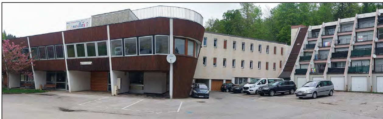
Photographie 7 : Aire de lavage
