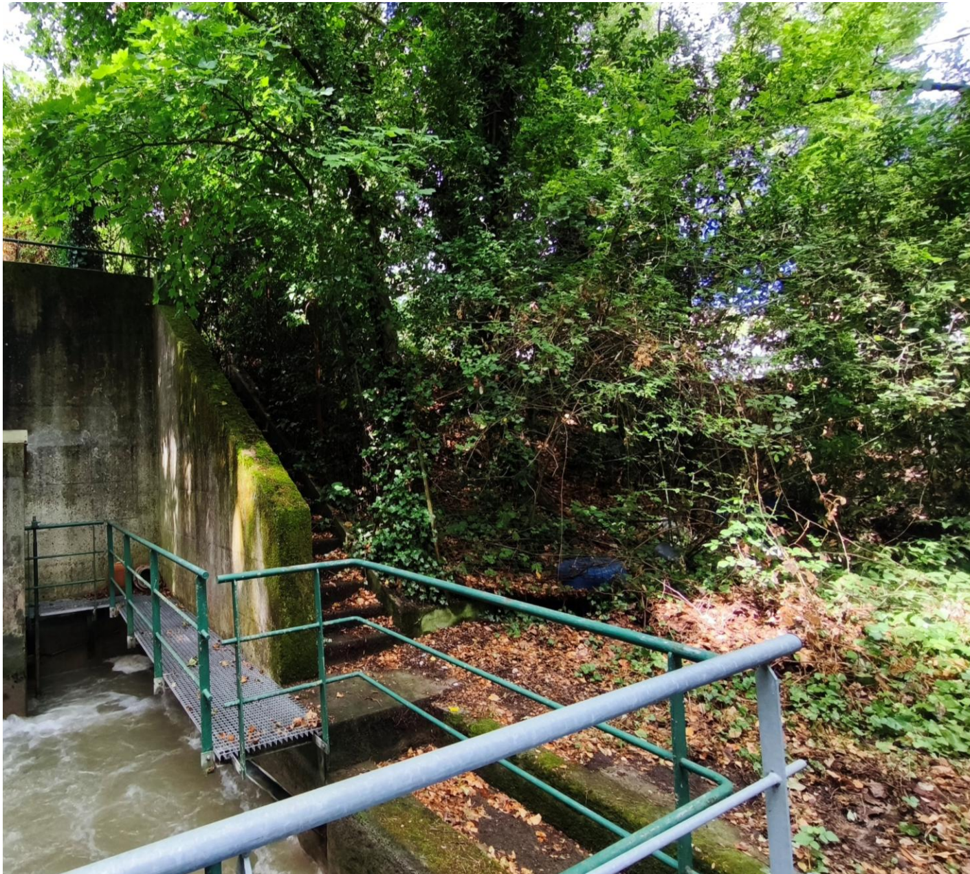
Dalle bétonnée, zone d'implantation du local technique – 21 juillet 2025
