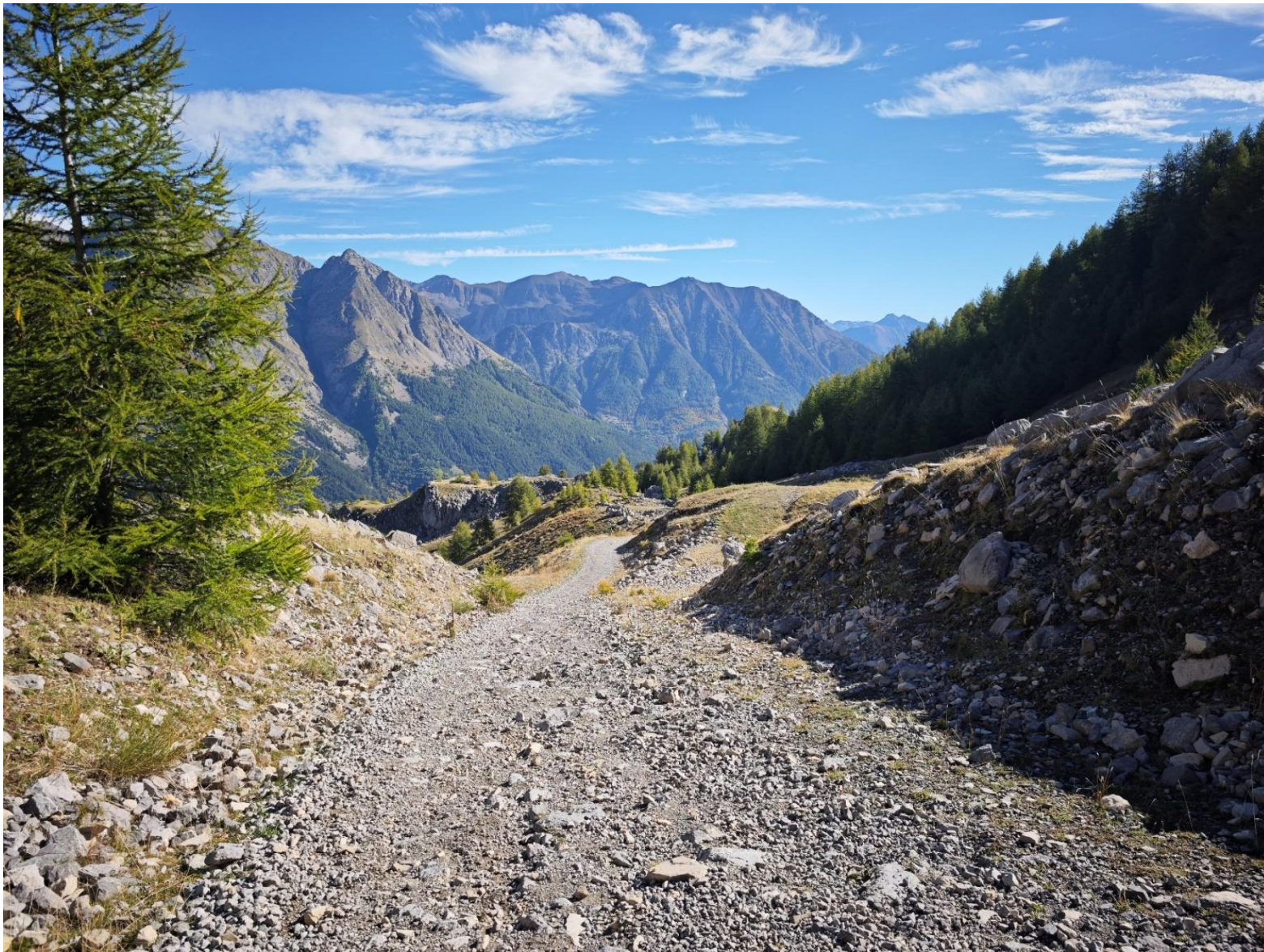
Figure 5 : Photographie 3 – Section de la piste Ripaaa à élargir
