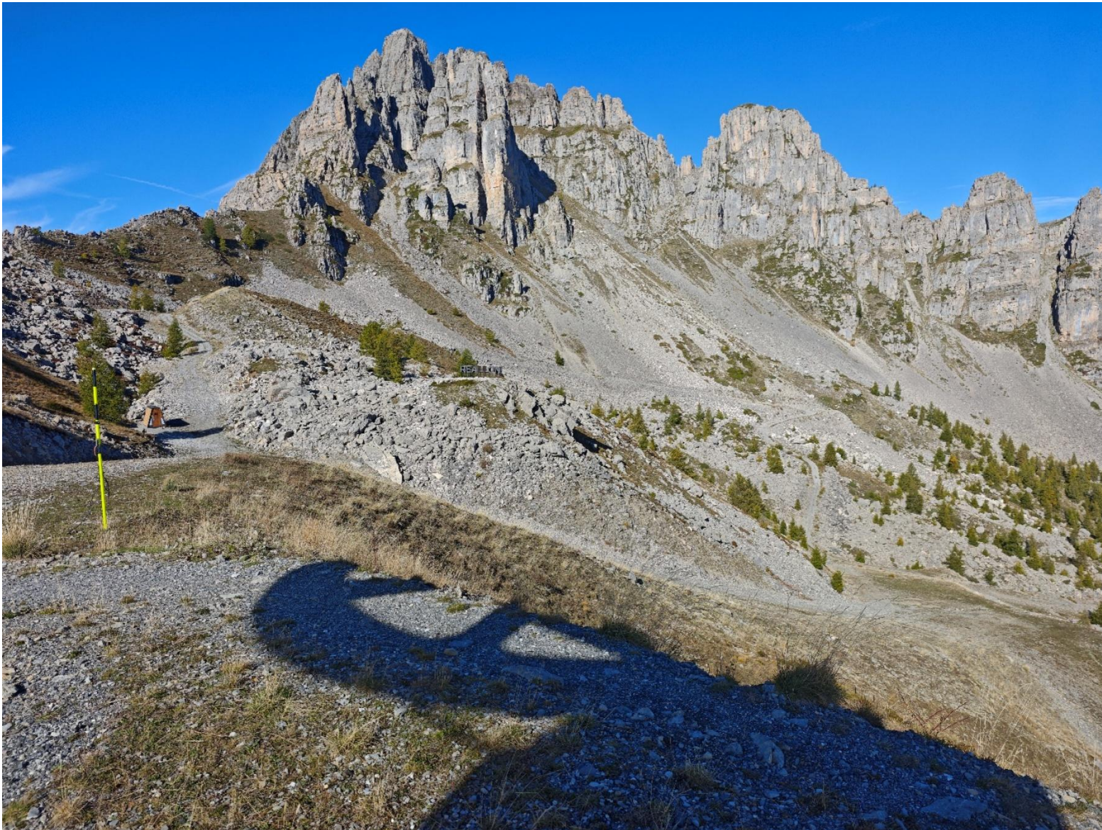
Figure 2 : Photographie 1 – Début de la piste Ripaaa vue depuis l'arrivée du télésiège de Chabrières
