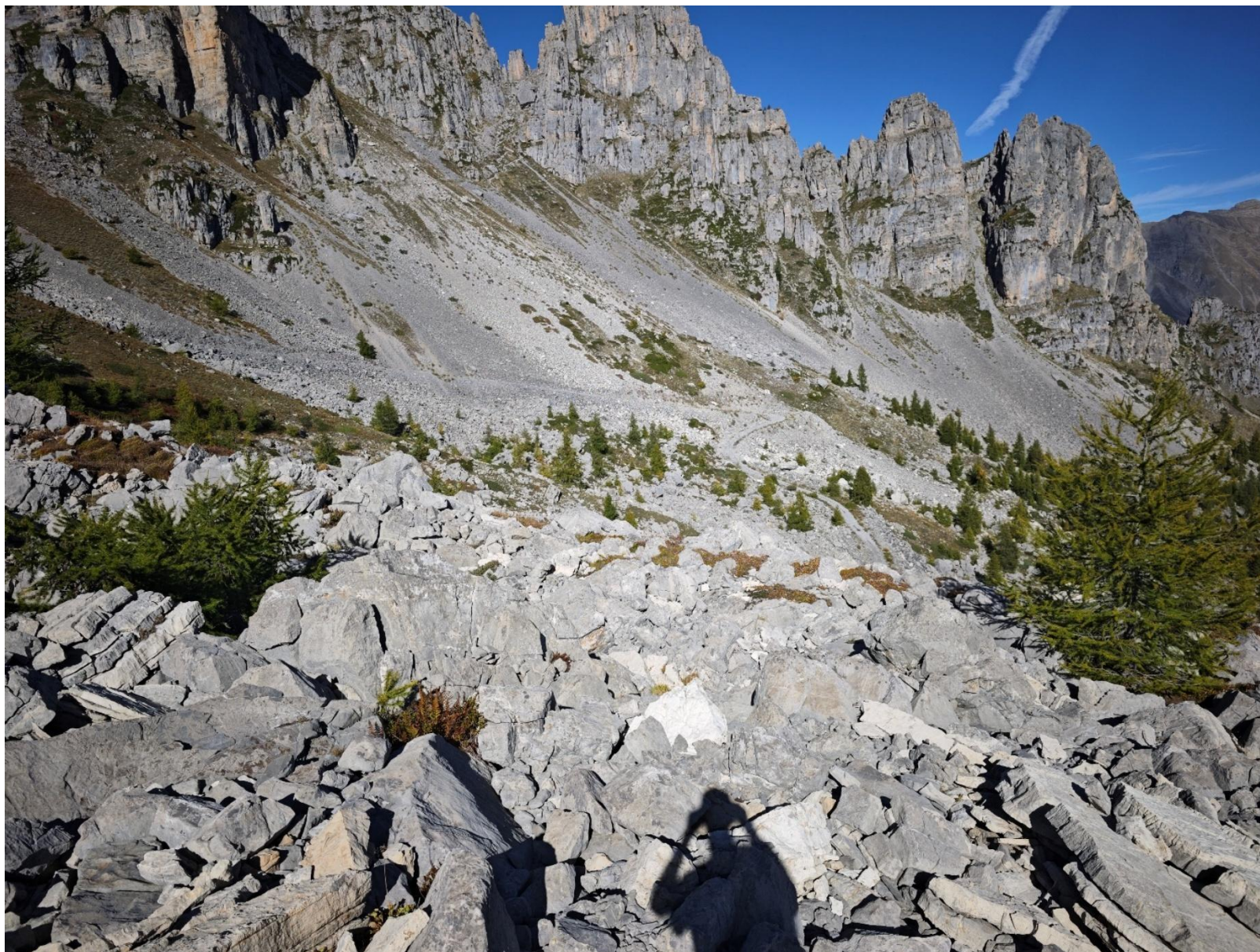
Figure 4 : Photographie 2 – Emprise de la nouvelle section de la piste Ripaaa
