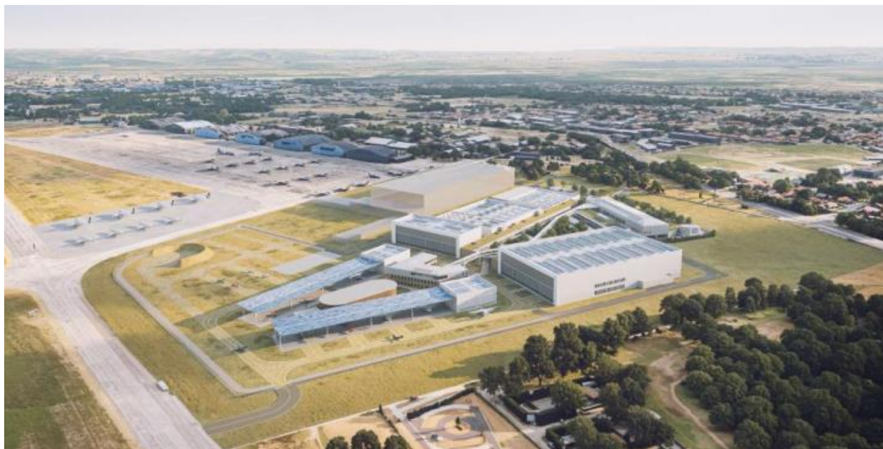
Figure 2 : vue aérienne sur le futur site Aura Factory depuis le nord-ouest (source : dossier)
