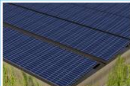
Panneaux photovoltaïque en toiture : Site en autoconsommation 4 106 m 2 d'emprise projetée Hauteur égout : +16m Hauteur faîtage : +16,55 Pentes de 9%, orientées Sud-Est
