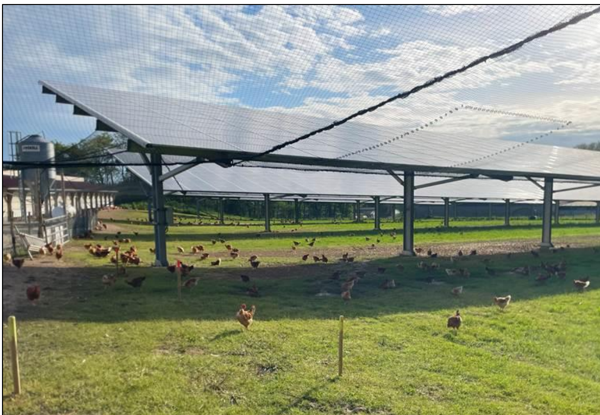
Figure 11 : Photographie d'une volière photovoltaïque Technique Solaire (47) dans le cas d'un élevage de poulets de chair, avec à gauche le bâtiment d'élevage relié directement aux panneaux solaires et à la clôture périphérique, formant un clos total.
