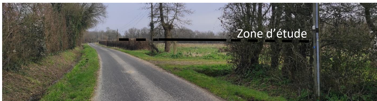
Figure 35 : Photo 20 : Vue directe à partielle sur la zone d'étude depuis le lieu-dit de la Chambaudrie.
