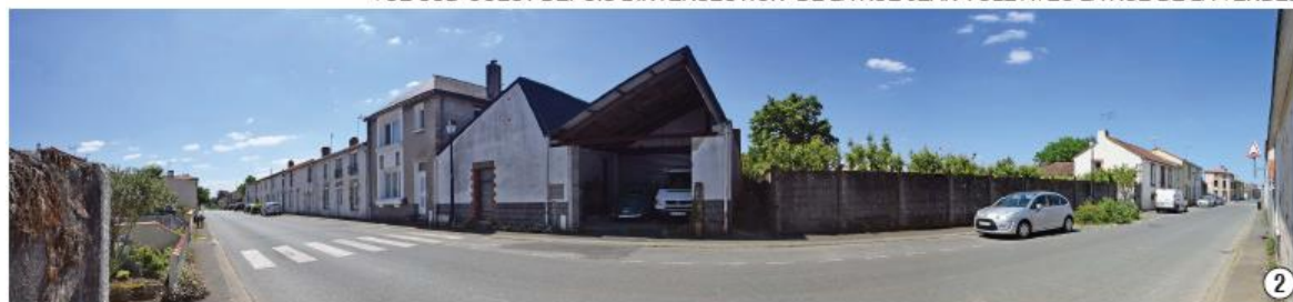
VUE OUEST DEPUIS LA RUE DE LA VENDÉE
