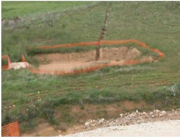
Illustration 9 - Fossés de collecte des eaux de chantier à faible pente
