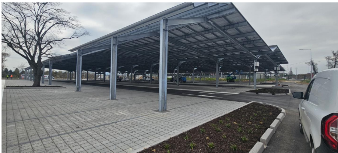
EXEMPLE IMAGE DE REF REVETEMENTS PAVES BETON JOINTS LARGES SUR STATIONNEMENTS (GRIS SUR LES PLACES, NOIRS POUR LES DELIMITATIONS DE PLACES) ET ENROBES SUR VOIES CIRCULEES (@PARKING F5 – EUROAIRPORT BALE MULHOUSE)
