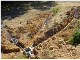
Tranchées remplies de plaquettes
