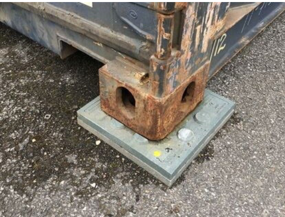
Pose sur dalle, pas de fondation
