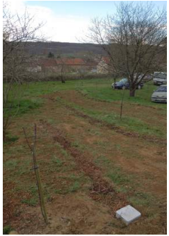
Tranchées remplies de BRF
