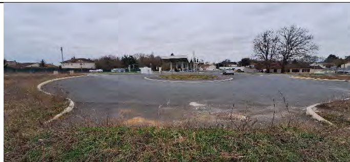
Vue du rond-point d'entrée déjà aménagé. Cette voirie, viabilisée (réseaux EU, EP, etc.), sera restituée à la collectivité.
