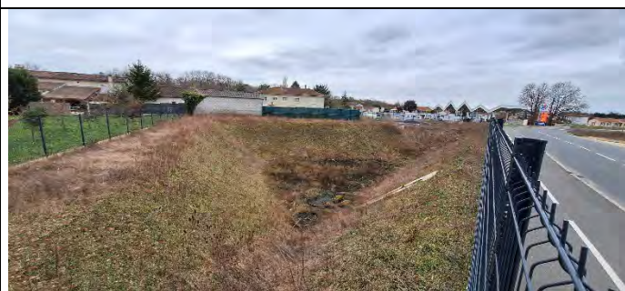
Bassin de rétention des eaux pluviales du site, d'un volume de 600 m 3 . Il est situé à proximité de la station-service. Parcelle AE77).
