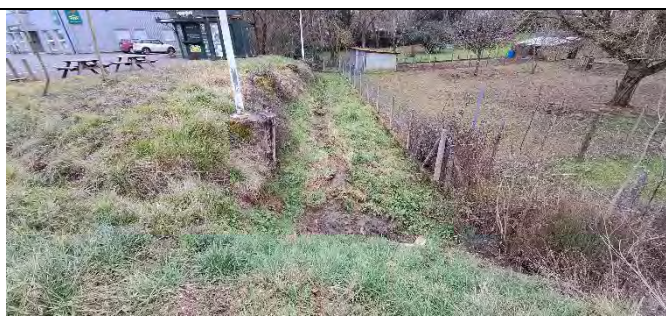
Fossé en aval du site, aboutissant via plusieurs fossés à la Seugne, située à 1,3 km en aval.
