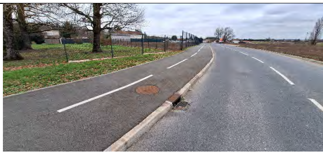
Longeant le site au sud, la voie d'accès, viabilisée. Ce bassin versant routier est intercepté et est géré par le bassin de rétention existant.
