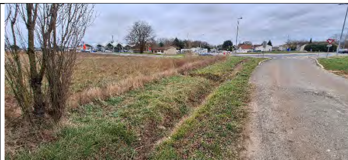
Fossé pluvial bordant le site à l'ouest (domaine public).
