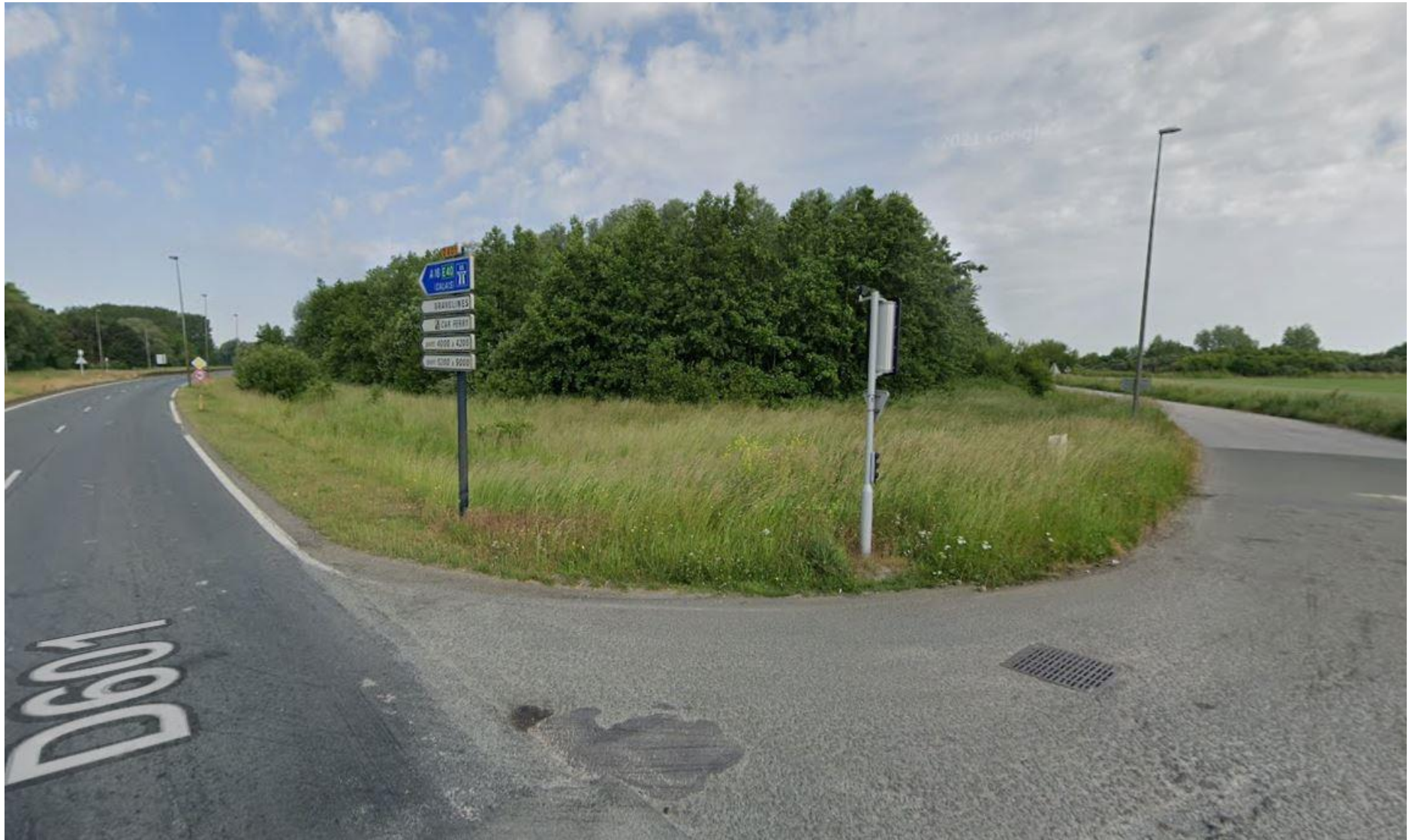
Figure 3: Vue du point n°2
