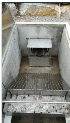
Figure 4 : Illustration de l'étape de dégrillage
