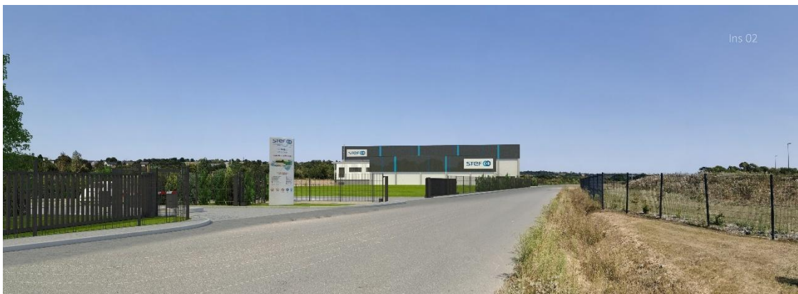
Figure 5 : Vue du projet depuis la voirie de desserte de la zone d'activité (sud)
