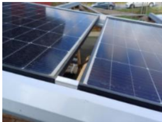
Figure 4 : exemple d'espace laissé entre les modules
