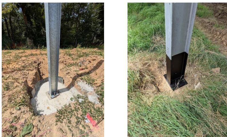
Figure 9 : Exemple de pieux forés bétons réalisés sur des projets de volières agrivoltaïques existantes
