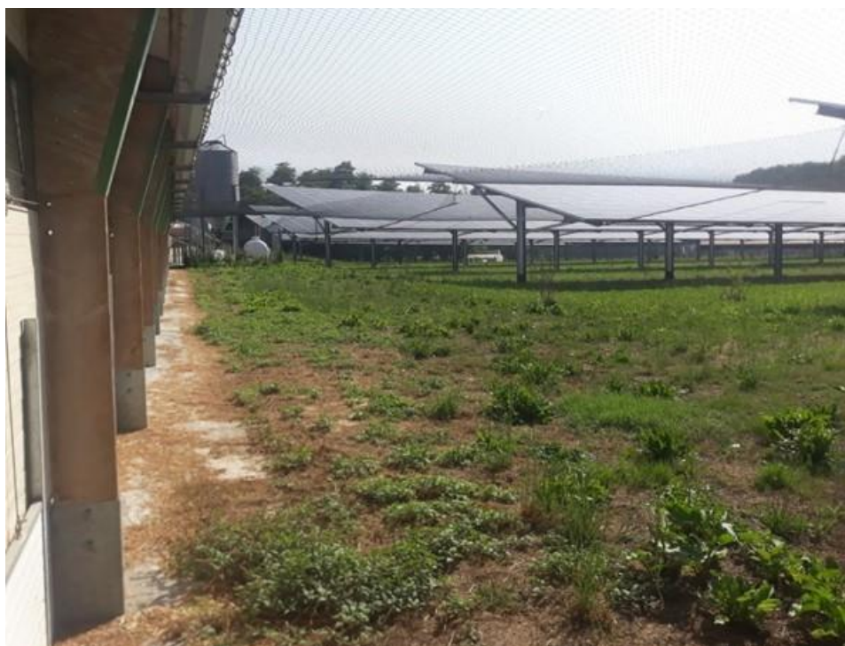
Figure 3 : Photographie d'une volière agrivoltaïque de Technique Solaire dans le cas d'un élevage de poulets de chair, avec à gauche le bâtiment d'élevage relié directement aux panneaux solaires et à la clôture périphérique, formant un clos total.
