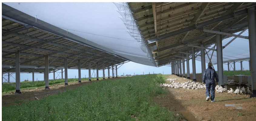
Figure 5 : exemple de couvert végétal présent sous une volière construite par Technique Solaire
