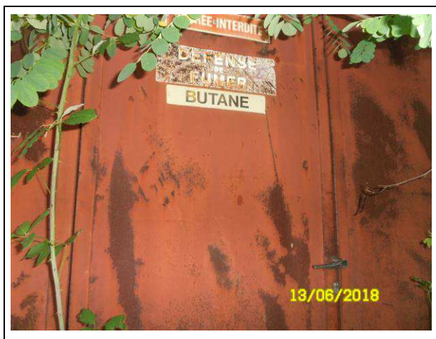
Vue de l'accès à l'ancienne chaudière du site.
