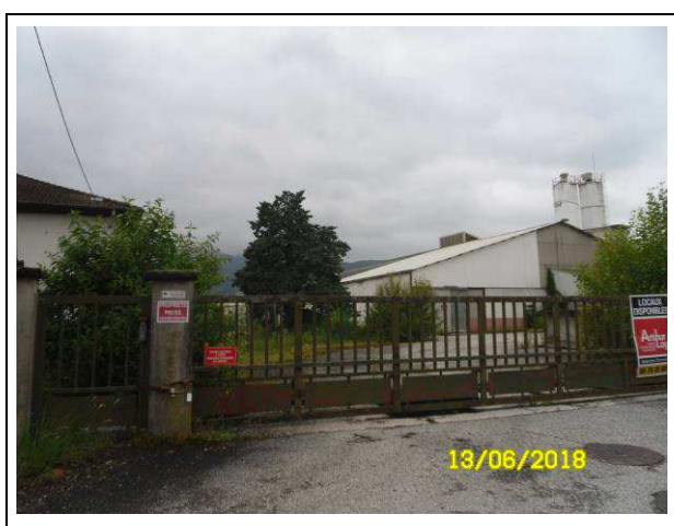
Vue de l'accès nord fermé par portail.
