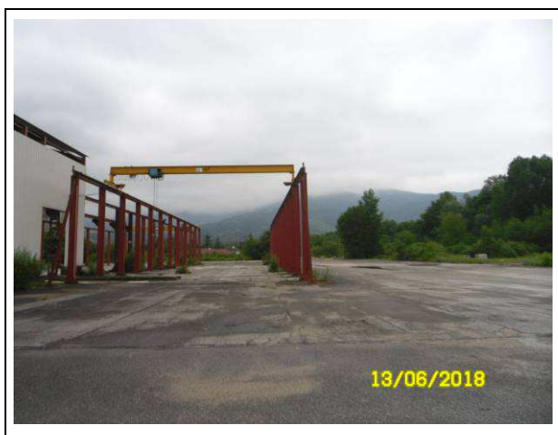
Vue en limite sud-ouest du bâtiment de production.
