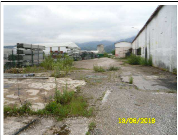
Vue en limite nord-est du bâtiment et du site.
