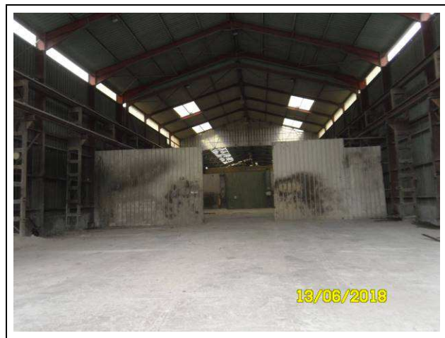
Vue vers l'atelier de production depuis le sud.
