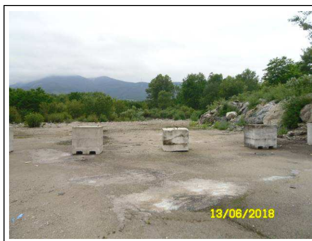
Vue en limite sud du site.
