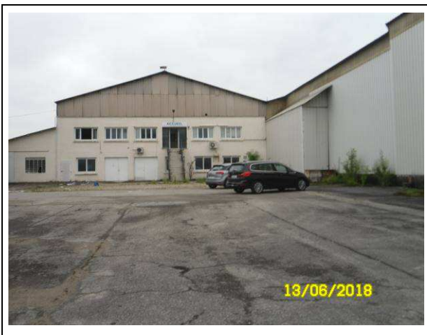
Vue vers l'entrée du bâtiment, côté bureaux.
