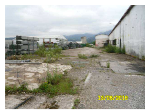
Vue des zones de stockage de ferrailles en extérieur.
