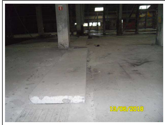
Vue de la canalisation d'évacuation des eaux de lavage dans l'atelier de production.
