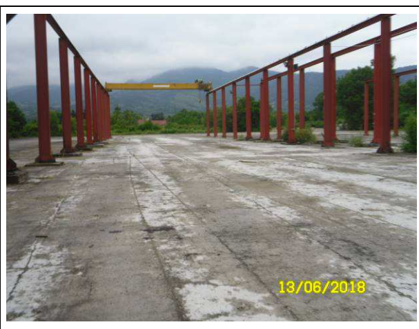
Vue de la zone de stockage des escaliers au sud.
