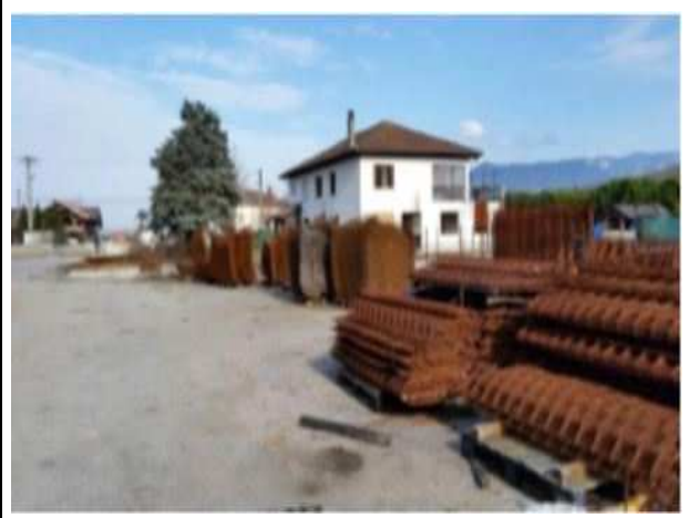
Vue du stock de ferrailles au nord-est du site.
