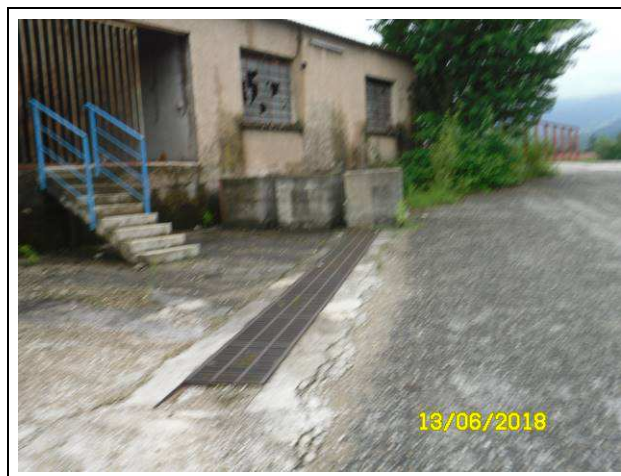
Vue de la façade ouest du bâtiment.
