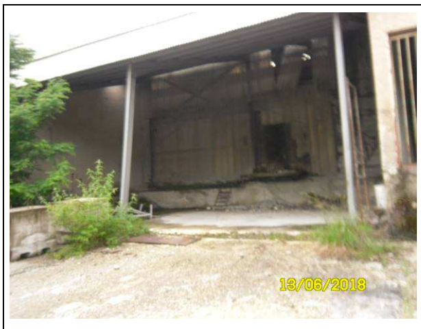
Vue vers le bac de décantation contre la façade ouest du bâtiment.
