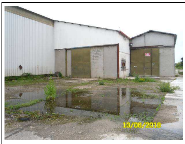
Vue en limite sud-est du bâtiment.
