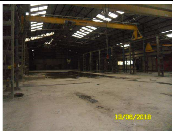
Vue dans l'atelier de production.
