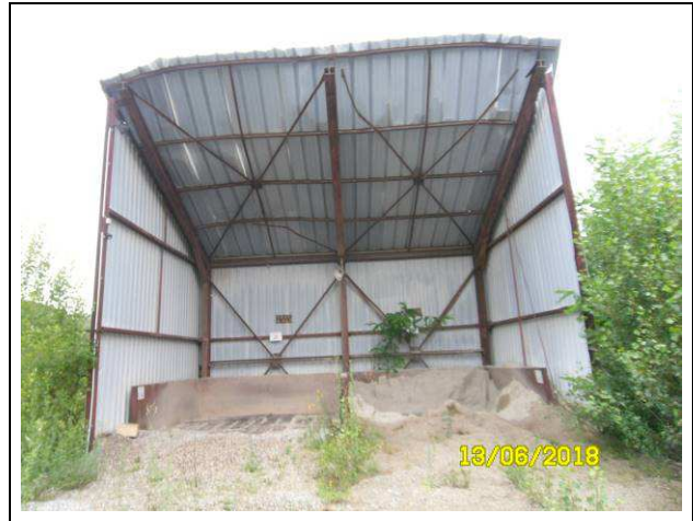
Vue du stockage des granulats sous abri au nord.
