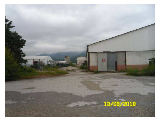
Autre vue en limite nord-est du bâtiment.
