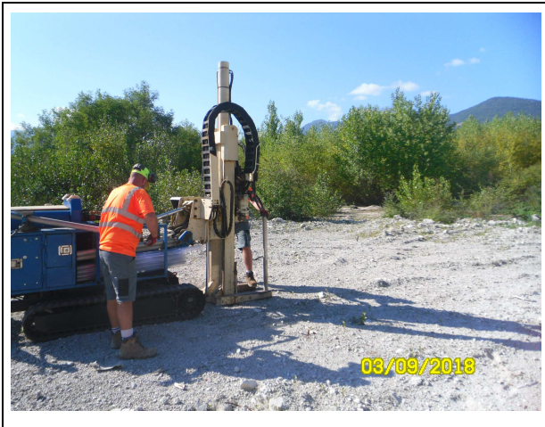
Vue de l'implantation du carottage S1.
