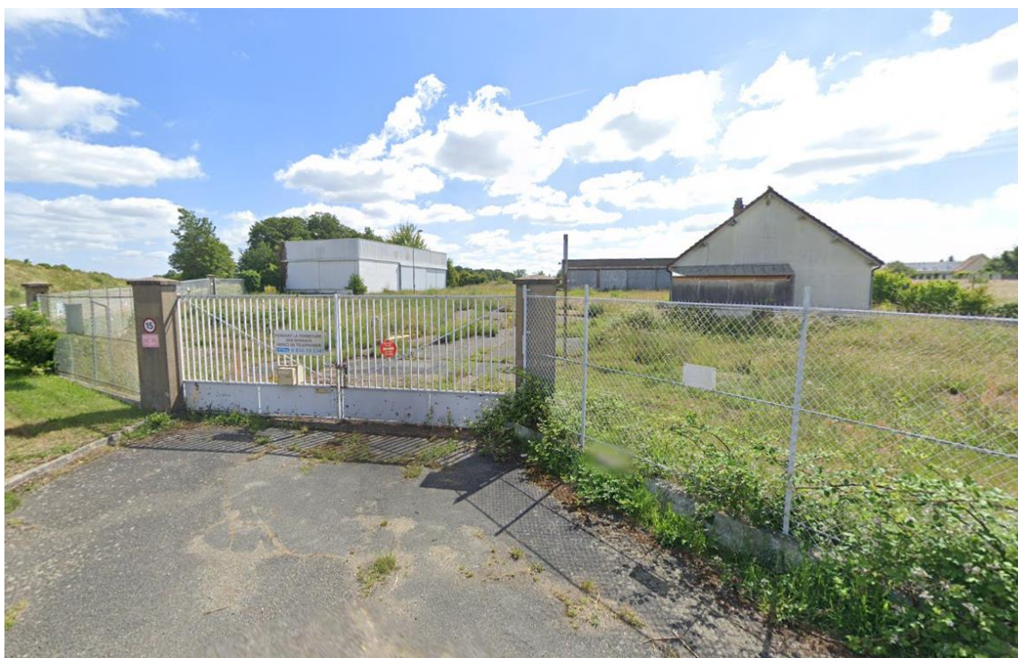
Figure 3 : Entrée de l'ancien site industriel de Worex
