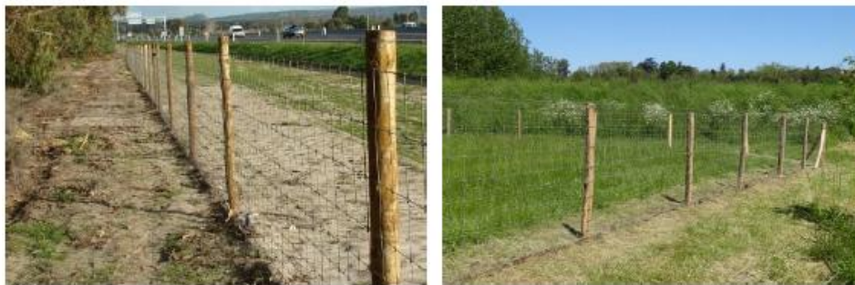
Figure 8 : Exemple d'une clôture de parc solaire
