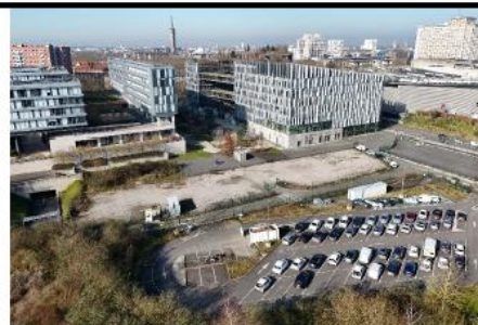
Façade depuis le périphérique
