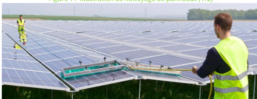
Figure 2 : Illustration de nettoyage de panneaux (2/2)
