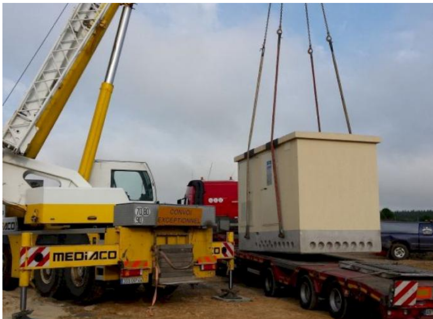
Figure 3 : Grutage du module préfabriqué
