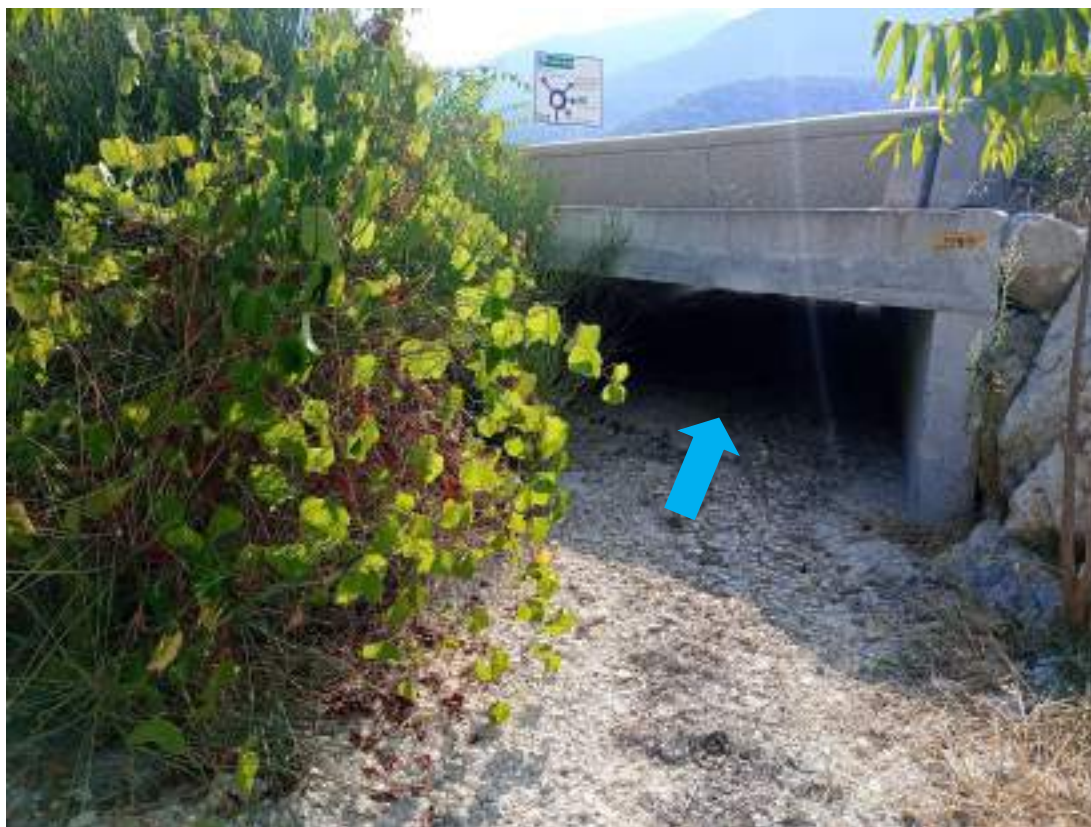
Photo 2 : Entonnoir amont de l'ouvrage de rétablissement sous la RD94
