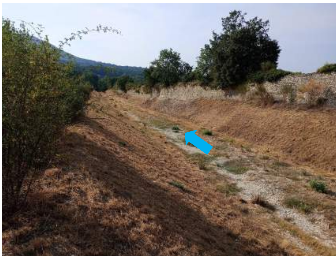
Photo 5 : Ravin du Ruinas à l'aval de la RD94 (depuis la rive gauche)
