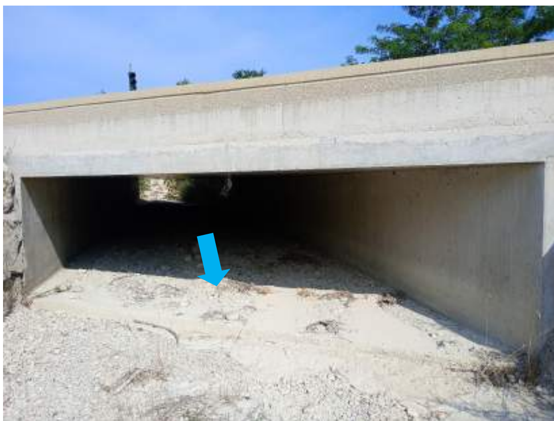
Photo 3 : Vue aval de l'ouvrage de rétablissement sous la RD94
