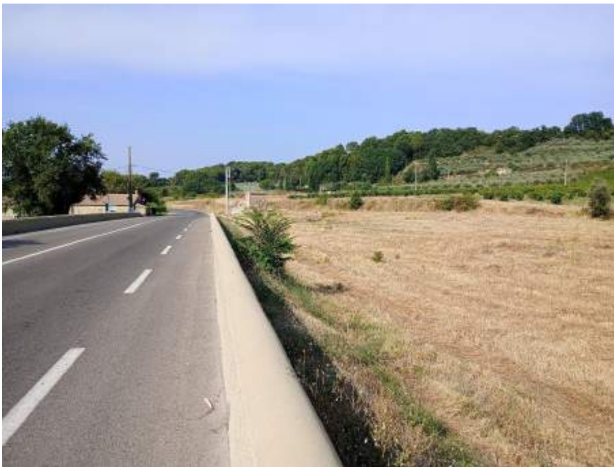
Photo 6 : Champ d'expansion de crue en rive droite du Ravin du Ruinas, à l'amont de la RD94
