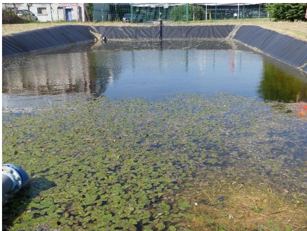
Photo 9 : Bassin de stockage d'eau (réserve à incendie), 18/09/2024, HD
