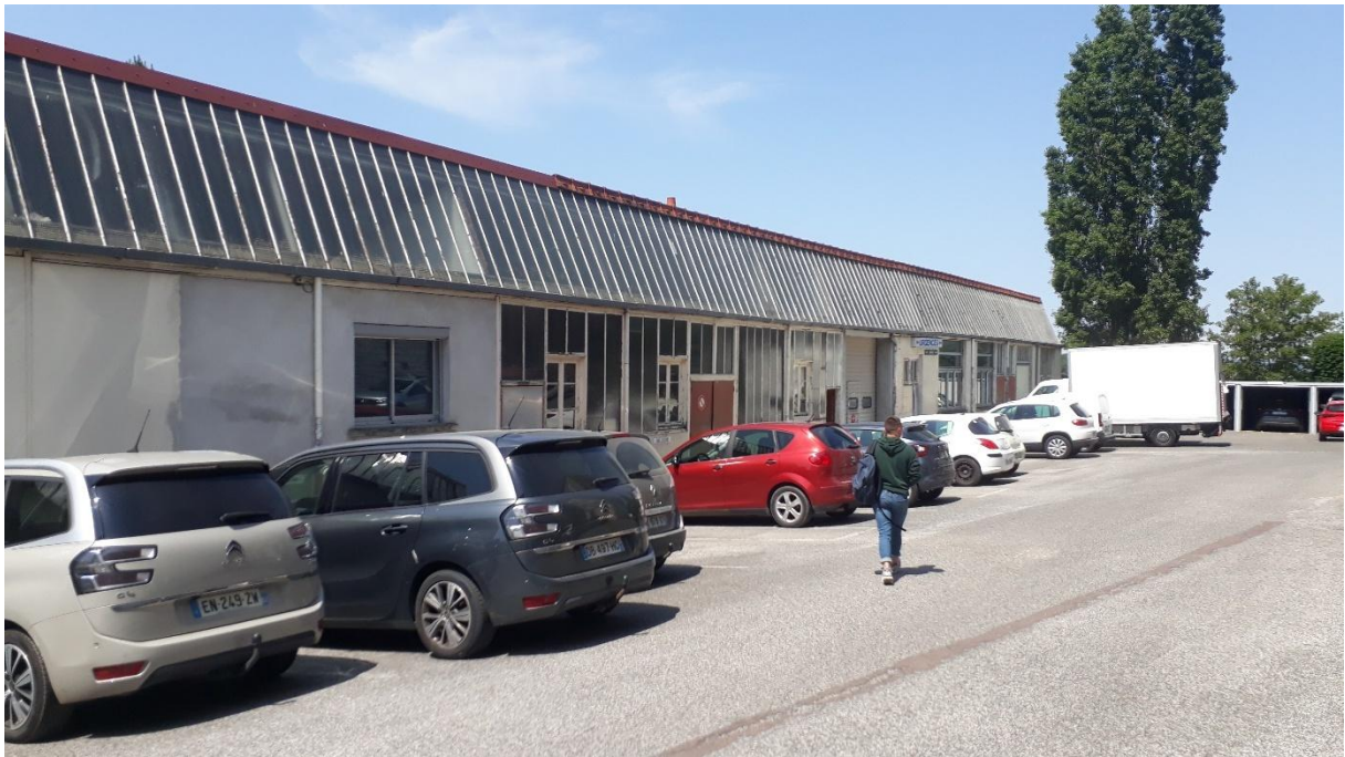
Figure 3 : Bâtiment 15 « Ateliers » (Source : Egis, 5 juin 2023)
