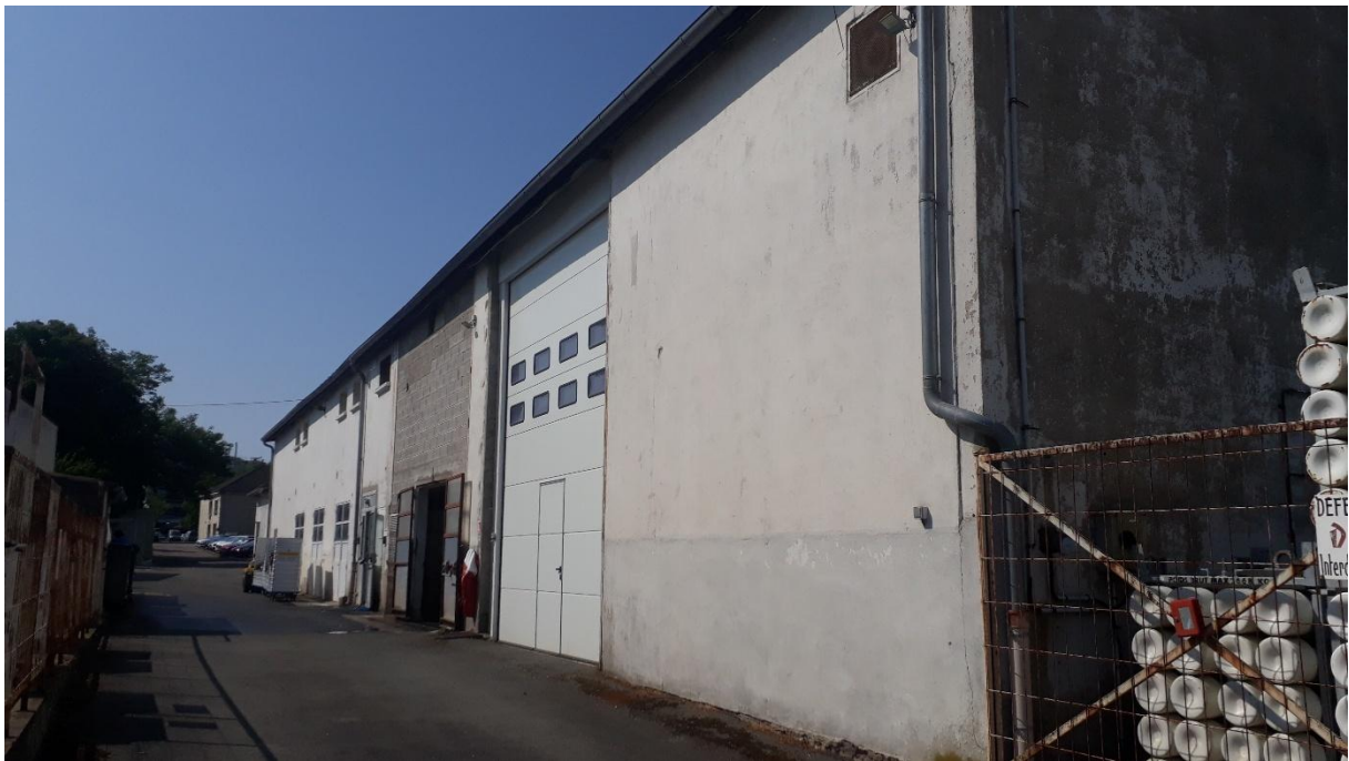
Figure 6 : Bâtiment 16 (ancienne chaufferie)
